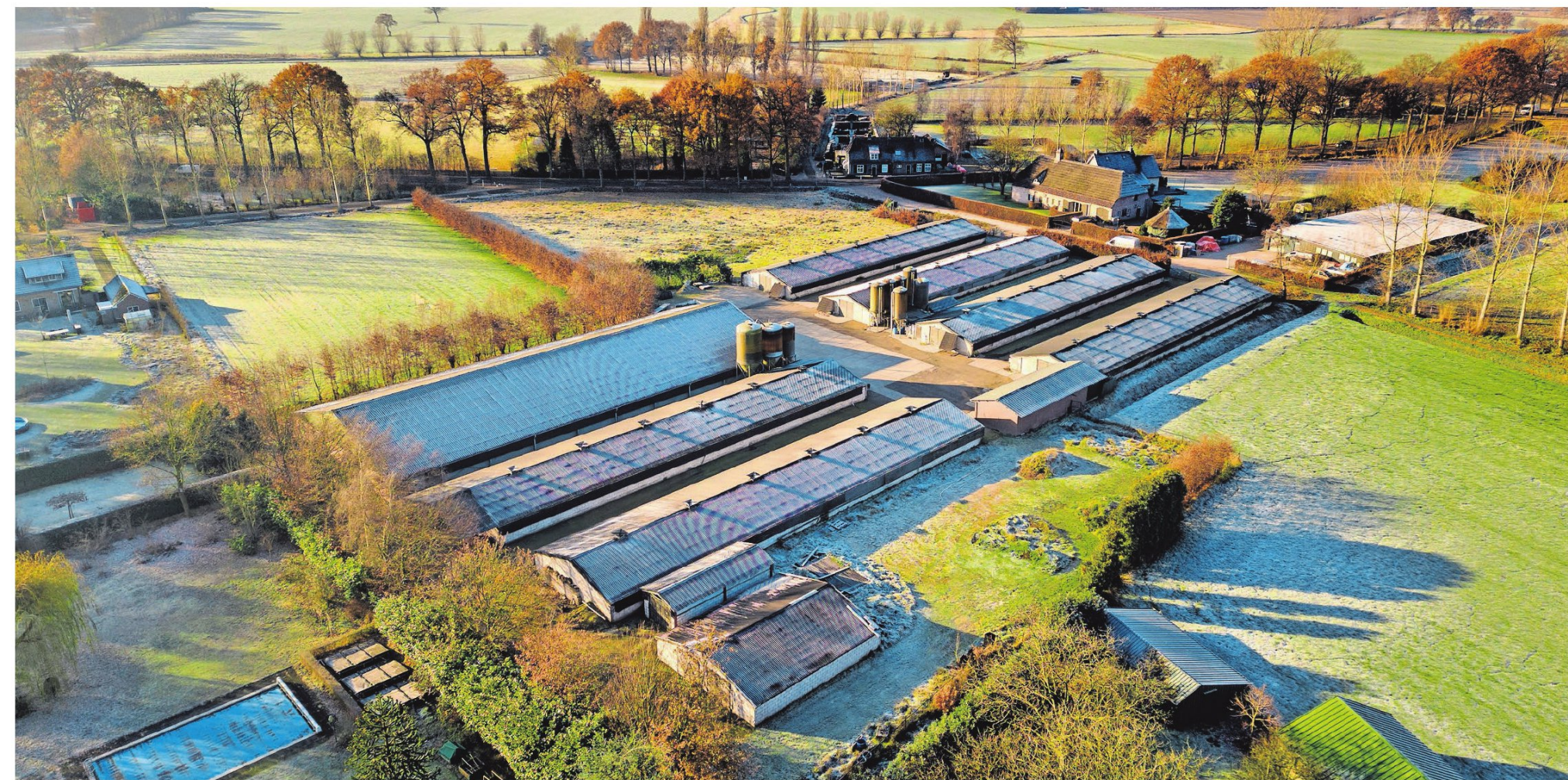
▲ Het pluimveebedrijf aan de Hezelaar tussen Gemonde en Sint-Michielsgestel. Er komen straks negentien Ruimte voor Ruimte-woningen voor in de plaats. FOTO MARC BOLSUIS
