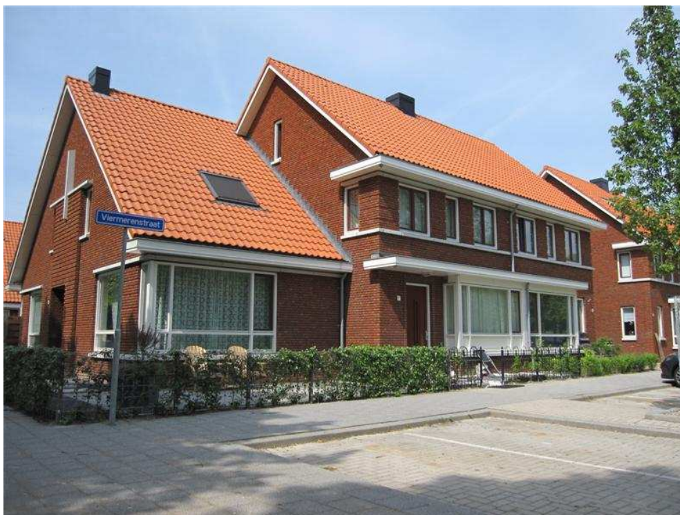
Figuur 4 Kleuraanduiding gevelsteen en dakpan.
