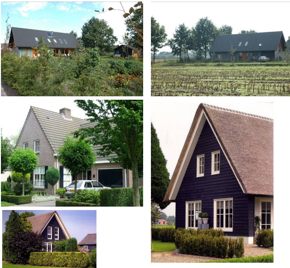
Figuur 10. Impressies van de woningen (voor de bebouwings-eisen wordt verwezen naar het hoofdstuk bebouwings- en gebruikseisen, omdat de getoonde afbeeldingen kunnen afwijken van de voorgestelde maten en met de impressies geen rekening is gehouden met mogelijke beperkingen van onder andere geluidsbelasting).
