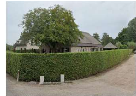
Langgevel met ruime tuin met huisboom
